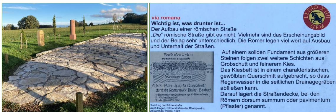
Abbildung 19 und 20: Nachbildung der römischen Straße (links) (ARGUS CONCEPT GmbH) und Aufbau der Römerstraße (rechts) (Infotafel am Ort des LEGIO XIII GEMINA e.V)
